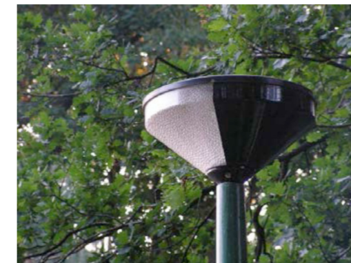
Figuur 11: Voorbeeld van een aangepast armatuur: afgeschermd naar boven en naar achteren (bron: Herman Limpens, Zoogdierversing).
