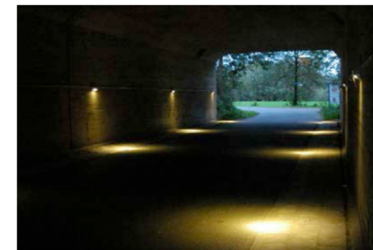
Figuur 10: Voorbeeld van aan vleermuisgebruik aangepaste verlichting in een brug: lage verlichting zorgt voor passeerbaarheid in het bovenste deel. Let op: werkzaamheid is alleen voor gewone grootoorvleermuizen aangetoond, voor andere vleermuissoorten is dit geen goede voorziening (bron: Herman Limpens, Zoogdierversing).
