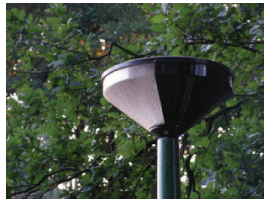
Figuur 11: Voorbeeld van een aangepast armatuur: afgeschermd naar boven en naar achteren (bron: Herman Limpens, Zoogdierverseniging; foto: Hans Huitema).
