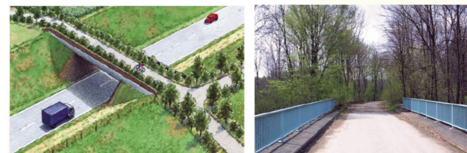
Figuur 16: Voorbeelden van voor ruige dwergvleermuizen als vliegroute te gebruiken viaducten over een weg (bron: brochure Met vleermuizen overweg).
